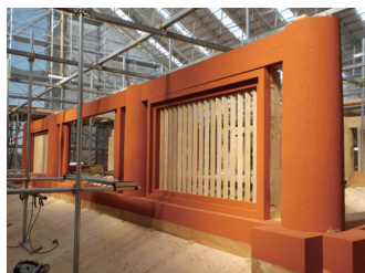
二重柱・頭貫と連子窓
